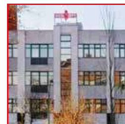
2006: se realiza una remodelación importante de la nave, restaurando su fachada principal e instalaciones
